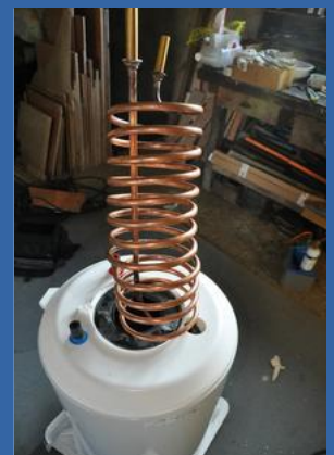
Recyclage et construction d'un chauffe-eau solaire thermique de démonstration
