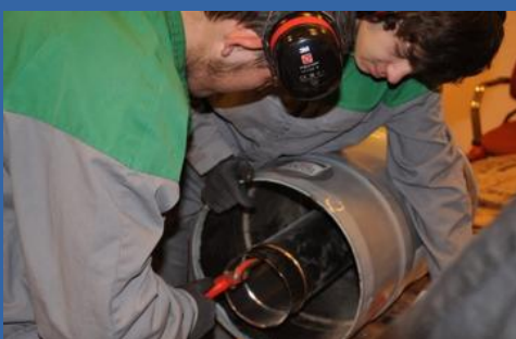
Construction d'un rocket stove
