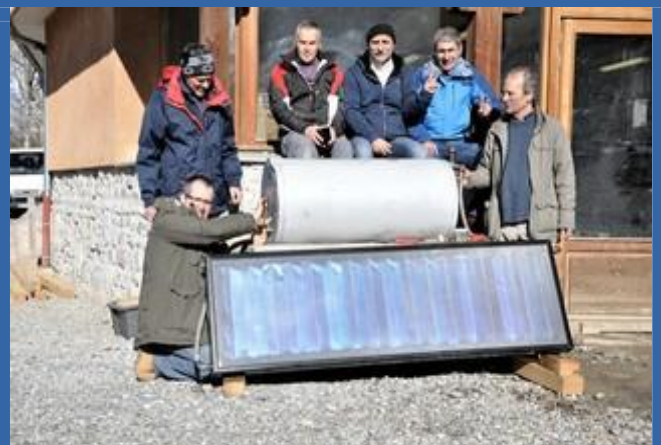
Février 2016, "Le Gabion", suivi d'un stage "solaire thermique" dans les Hautes-Alpes
